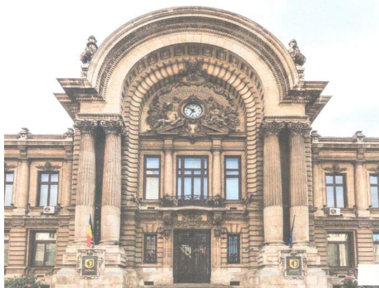
Fig. 1 Fațada Casei de Depuneri și Consemnațiuni
